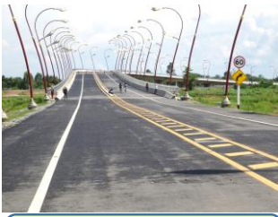
完成した橋(現在は橋の途中で通行止め)
